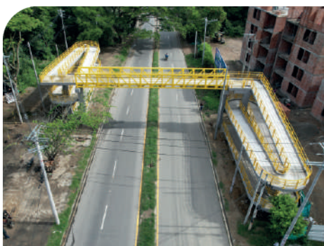
Puente peatonal Garzón
