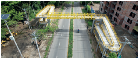
Puente peatonal Garzón
