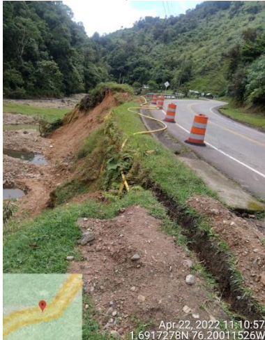
Figura 3.9 Sector perdida de banca por socavación de cuerpo de agua en la UF5.
