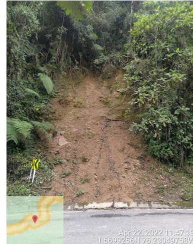
Figura 3.11 Sector de roca sedimentaria alterada y niveles residuales afectados por erosión superficial en la UF5.
