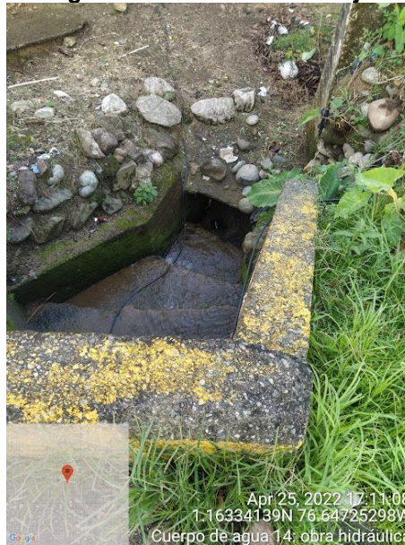
Figura 3.53 Obras de drenaje
