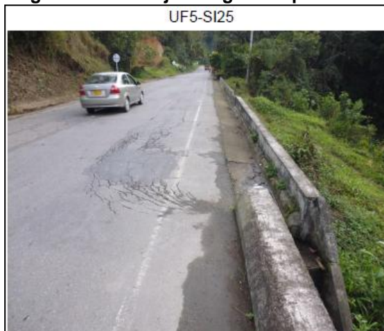
Figura 2.14 Manejo de aguas superficiales
