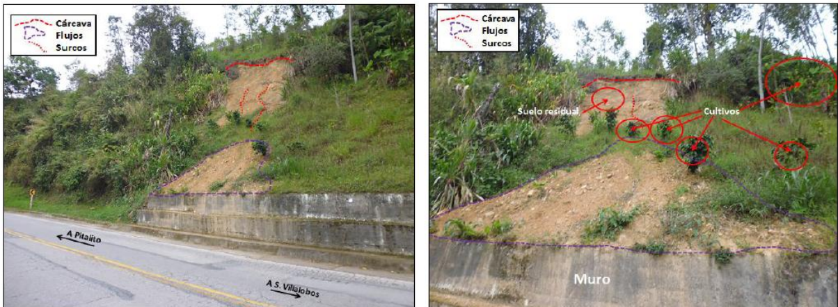
Figura 2.20 Deslizamiento traslacional de Talud Superior y Escarpes
