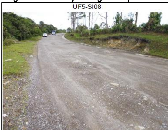
Figura 2.15 Manejo de aguas superficiales
