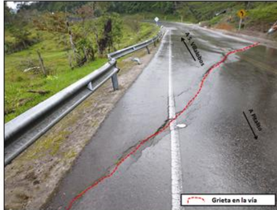
Figura 2.25 Sentido del Movimiento Sitio Inestable 13 PR88+800
